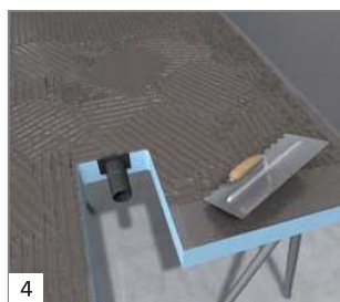
4 Daarna de achterzijde meteen lijmkam (10 mm tanding) tegellijm aanbrengen.
